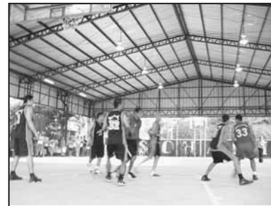
La Alcaldía de Apopa ha remodelado 7 espacios recreativos y deportivos entre ellos el Gimnasio Schafik Hándal, con objetivo de prevenir a la violencia juvenil y contribuir a la estrategia de ciudades seguras. Esta mega obra tiene un monto de: $ 242,012.50
