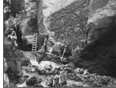
Construcción de muros de mitigación de riesgos con gaviones en lotificación y pasaje El Río, primera etapa, San Luis, Mariona. La inversión hacienda a más de $37 mil dólares, vale la pena destacar que la comunidad trabaja junto a los empleados municipales incluyendo los fines de semana.
