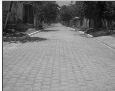
Con un Gobierno Municipal del FMLN, en Jiquilisco las quebradas las convertimos en calles transitables para nuestra gente. Adoquinado completo de 3094.93 mts 2 en la 5ta. Avenida norte y sur, del Barrio La Merced y Barrio San José, beneficiando a unas 5,000 personas que transitan por el lugar. Proyecto con un monto de $71,581.26.
